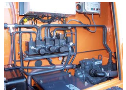
Geschützte und gut zugängliche Aggregate-raum für alle Steuerungselemente
